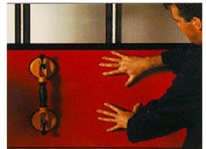
A distância entre os painéis de revestimento após o seu posicionamento deve ser a suficiente, de modo a evitar o contacto entre eles aquando de uma eventual dilatação da estrutura.
