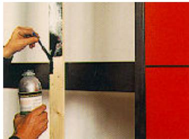
Não utilizar Sika® Cleaner-205 contaminado, velho, esbranquiçado ou gelificado. Sika® Cleaner-205 deixa um aspecto esbranquiçado na superfície. Tratar apenas a zona destinada à colagem.
